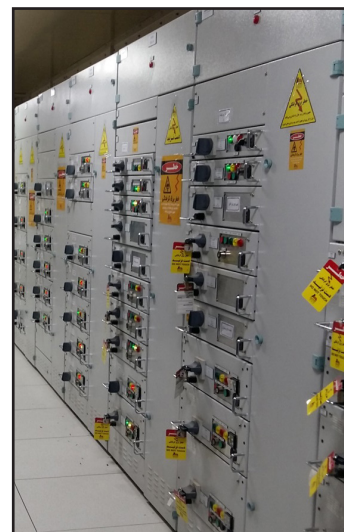
شکل ۱۰- ژنراتور و اتاق کنترل واحد MGT-40
